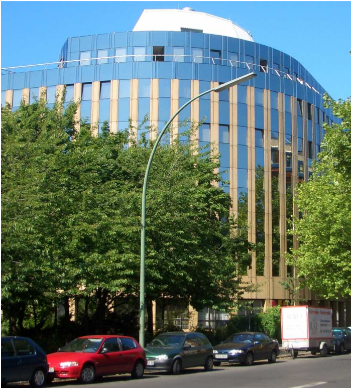
Ansicht Gebäudeteil Nr. 113, insgesamt ca. 9.000 m 2 NGF
