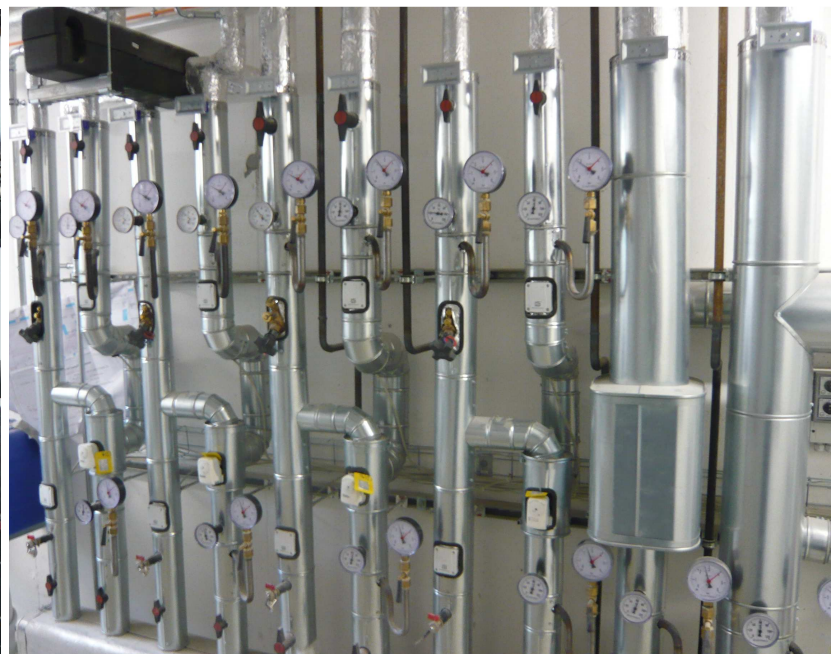
Heizungsverteiler mit Strahlpumpen
